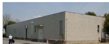
【中水システム設備】
