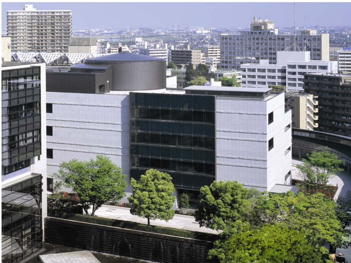
【大学1号館の太陽光発電モジュール組込ガラススクリーン(松戸キャンパス)】
