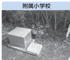
「聖徳の子農園」地下水くみ上げ給水施設の設置
