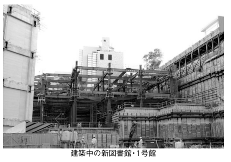
建築中の新図書館・1号館
