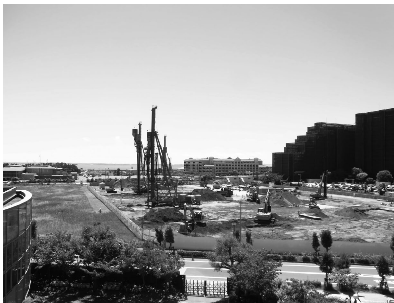
着々と進むホテル建設の現場
