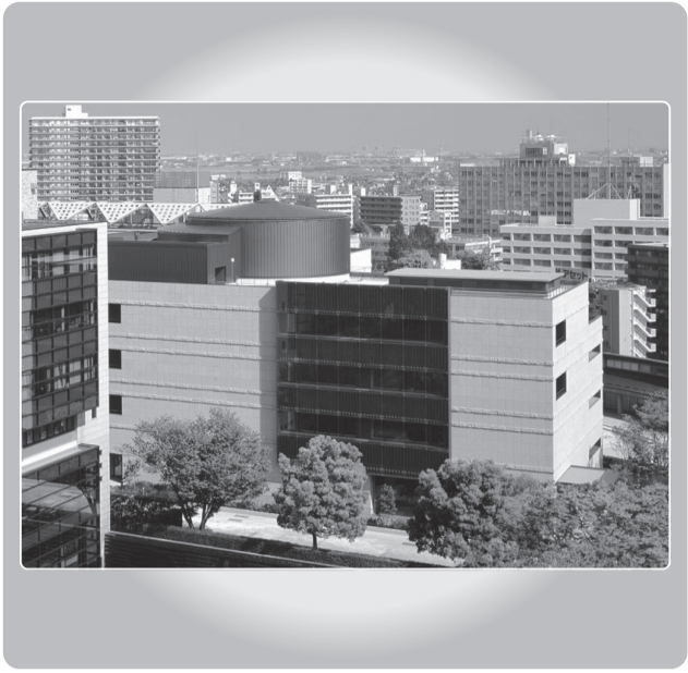
大学1号館の太陽光発電モジュール組込ガラススクリーン (松戸キャンパス)
